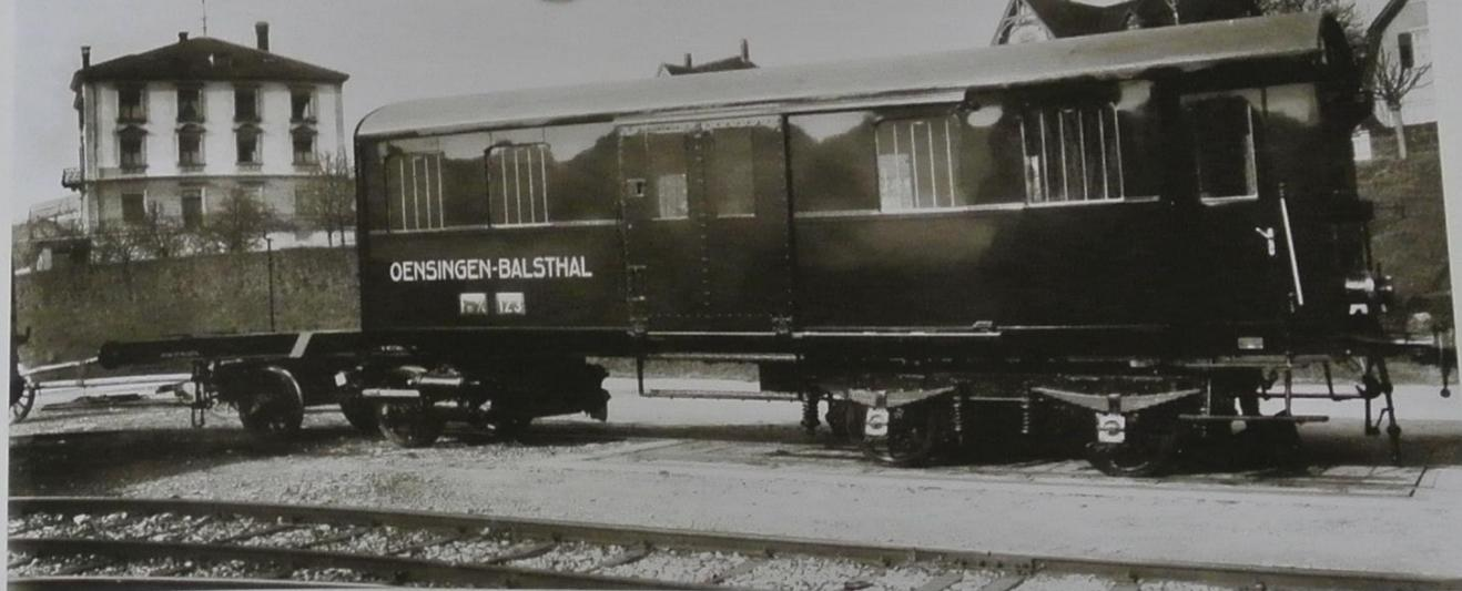
«Bereit zum Abtransport nach Winterthur»: Die Foto dokumentiert den OeBB-Dampftriebwagen Fm 2/4 123 im Zustand, wie er von der SIG an die SLM übergeben worden ist. Entstanden ist das Bild in Neuhausen, Winter 1929/30. Foto SIG/Slg. SBB Historie
